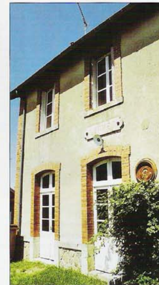
Station Lormes is prachtig bewaard. Alleen de klok is verdwenen.
